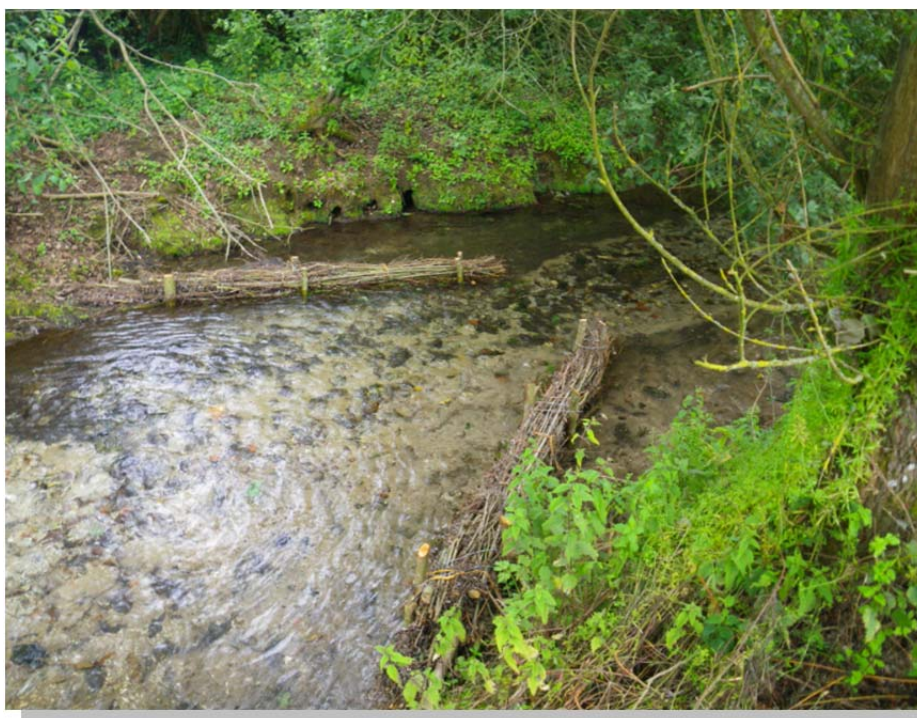
Création d'un déflecteur sur le ruisseau St Vaast afin de diversifier les habitats aquatiques
