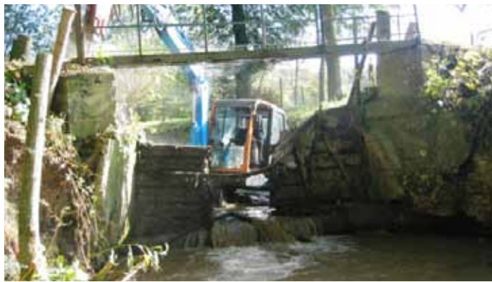
Démantèlement de l'ancien ouvrage (Crédit photographique : FDAAPPMA 62)
