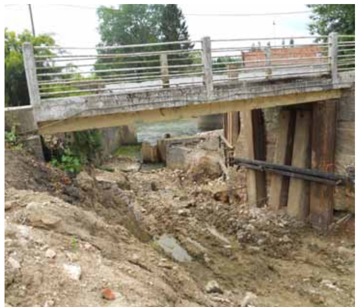
Confortement des bajoyers supportant le génie civil des passes, vue de l'amont (Source : S.M. SAGE Canche)
