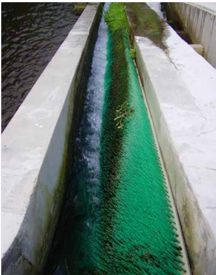
Construction d'une passe de type « tapis-brosse » adaptée aux anguilles (Source : AEAP)
