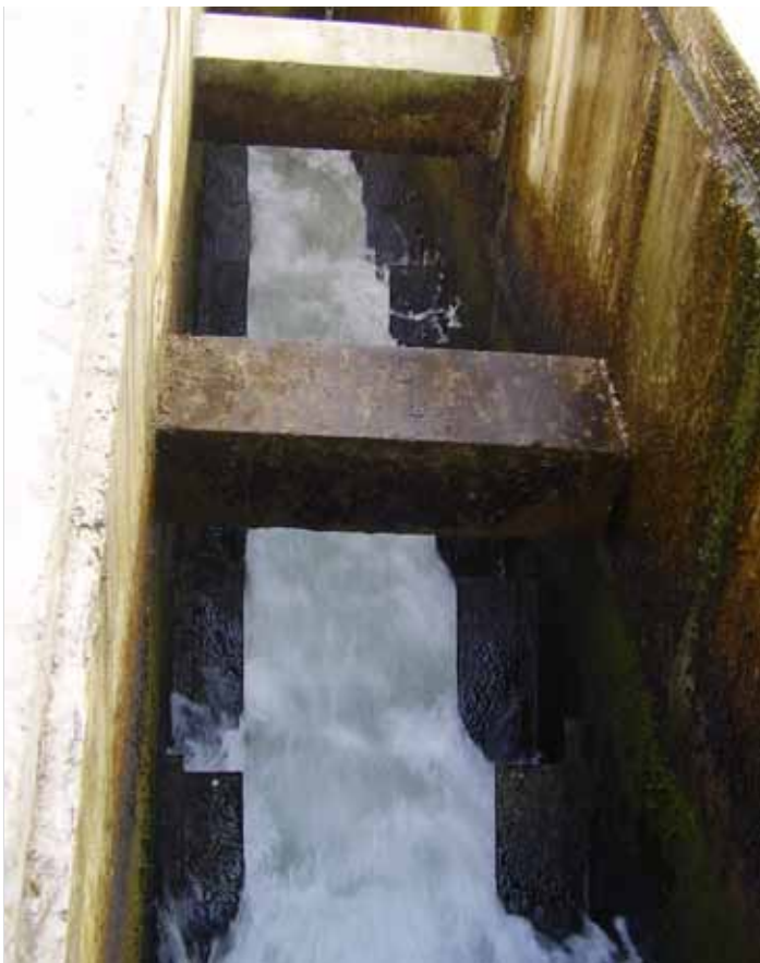
Construction d'une passe à ralentisseurs adaptée aux salmonidés (Source : AEAP)
