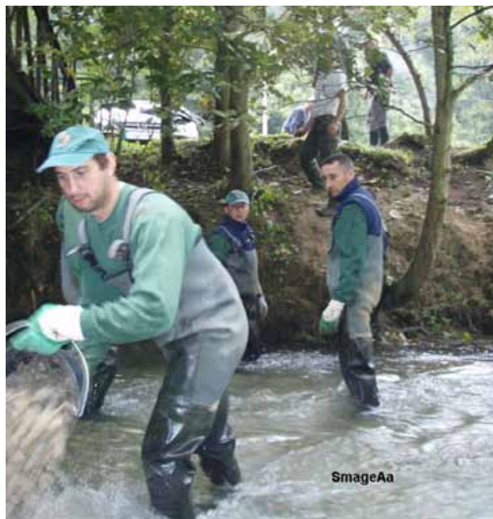
Mise en place des graviers 20-40 mm
