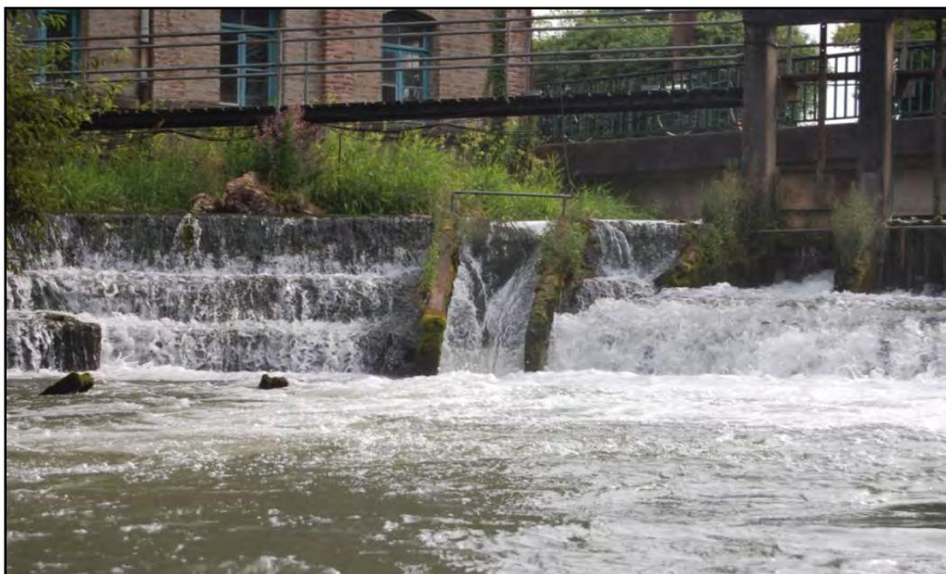
*Figure 62 : Vue aval de la rigole rudimentaire en rive droite ( $Q = 8\text{m}^3/\text{s}$ ) (FDPPMA 62)*
