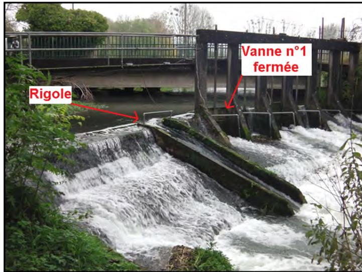
Figure 314 : Vue aval du barrage de Douriez ( $Q = 8 \text{ m}^3/\text{s}$ ) (FDPMA 62)
