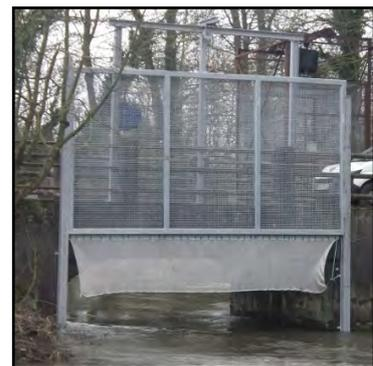
*Figure 12 : Bavette en caoutchouc et filet plombé, évitant l'échappement sous la porte coulissante (FDPPMA 62)*
