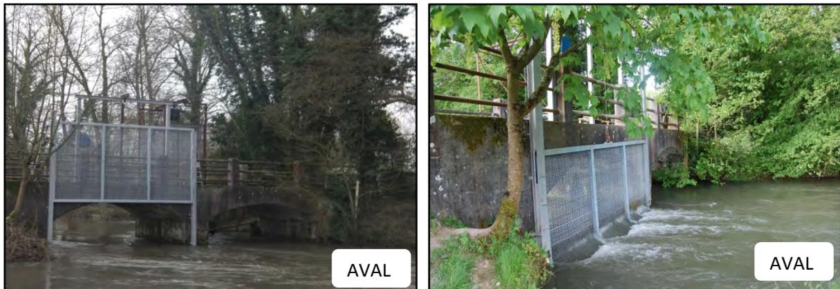
*Figure 11 : Vue de la porte coulissante hors d'eau (photo de gauche) et en fonctionnement (photo de droite) (FDPPMA 62)*
