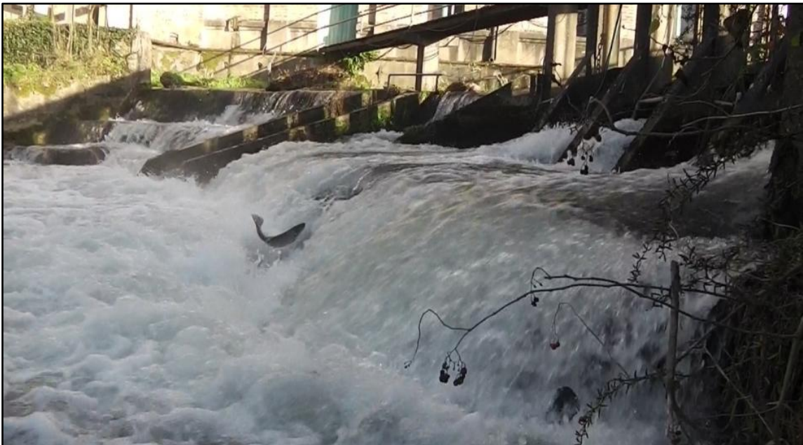
Figure 28 : Tentative de franchissement au barrage de Douriez sur l'Authie, observé à l'automne 2013 (FDPPMA 62)
