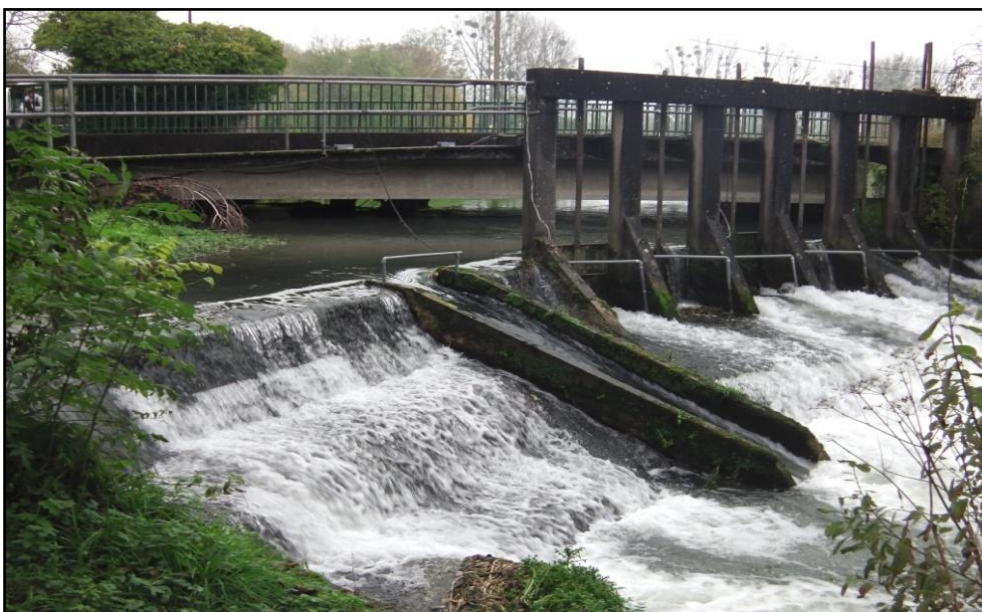
Figure 4: Antennes de radio-identification équipant le barrage de Douriez (FDPPMA 62)
