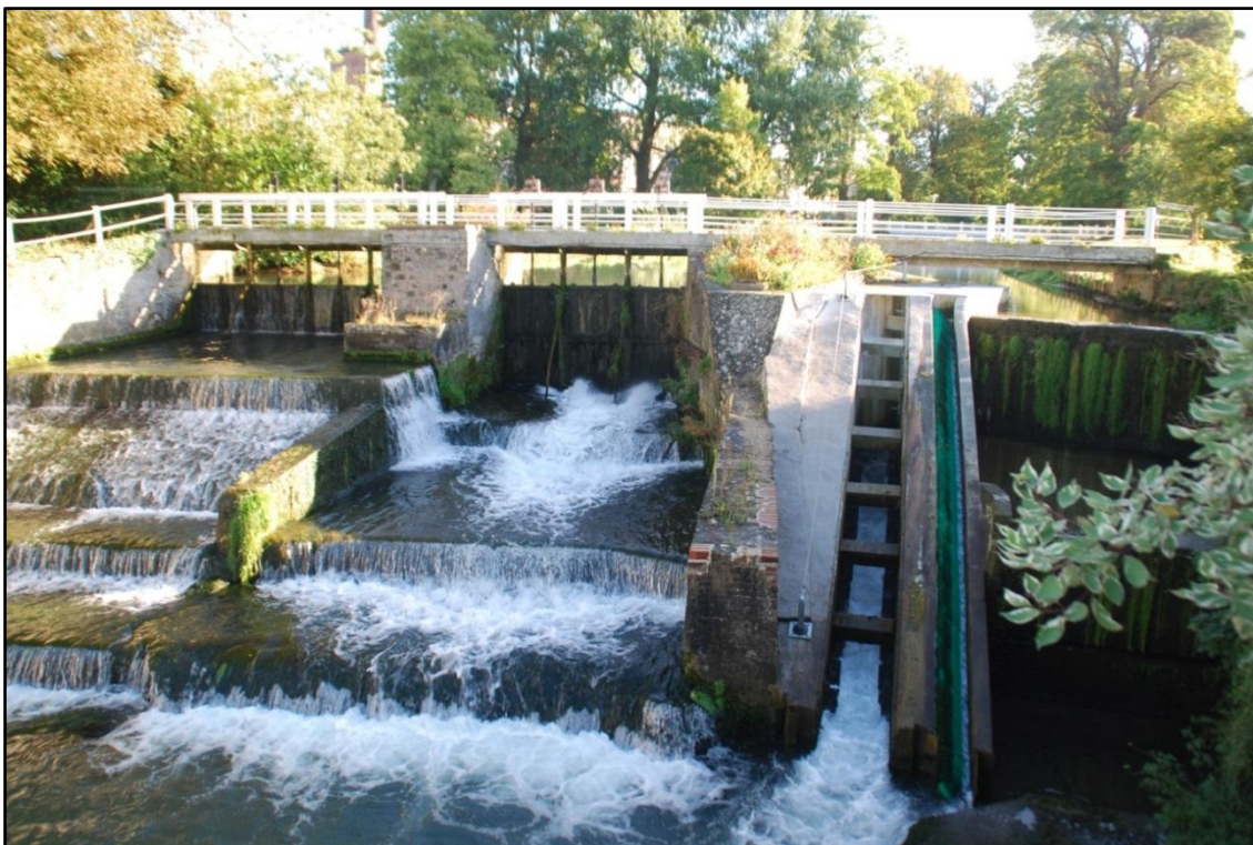
► Figure 2 : Barrage d'Auchy lès Hesdin et entrées des dispositifs de franchissement
