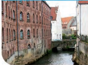
Monument historique après effacement d'ouvrage
