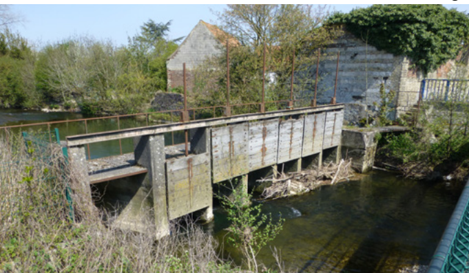
Etat initial - Vue amont de l'ouvrage
