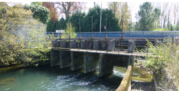
Etat initial - Vue aval de l'ouvrage
