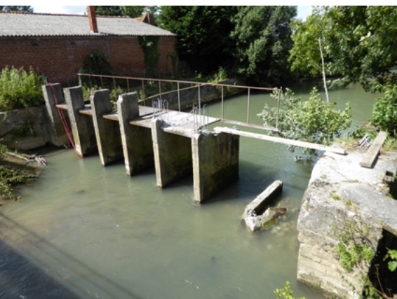
Arasement des 5 bajoyers et suppression de la passerelle
