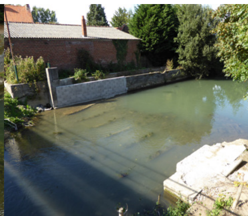
Etat final après travaux
