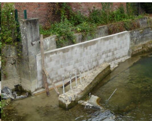
Déplacement et obturation de l'entrée du coursier, en rive gauche
