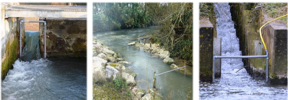
► Figure 21 : Exemples d'antennes de radio-identification, de gauche à droite, sortie de la passe à bassins de Blangy sur la Ternoise, entrée du bras de contournement de Blingel sur la Ternoise et entrée de la passe à ralentisseurs de Montcavrel sur la Course (FDPPMA 62)
