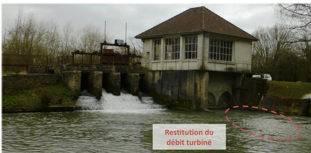
► Figure 76 : Barrage de Blingel (FDPPMA62)
