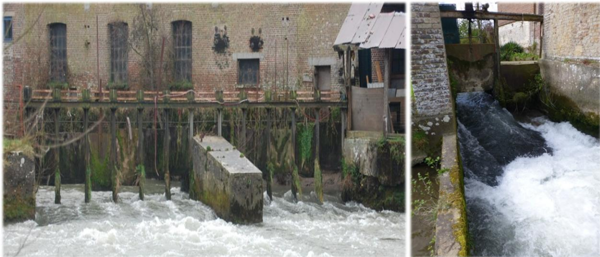
► Figure 50 : Vue d'ensemble de l'ouvrage principal (ROE 23475) sur l'axe Canche et des vannes sur la Fausse Canche (ROE 23478) après ouverture le 1er janvier 2016 (FDPPMA62)
