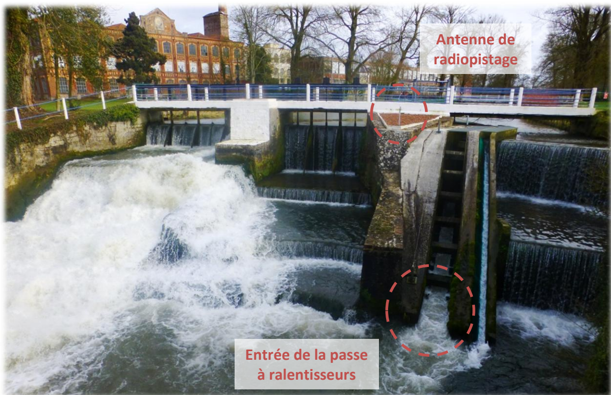
► Figure 73 : Barrage d'Auchy-lès-Hesdin (FDPPMA62)
