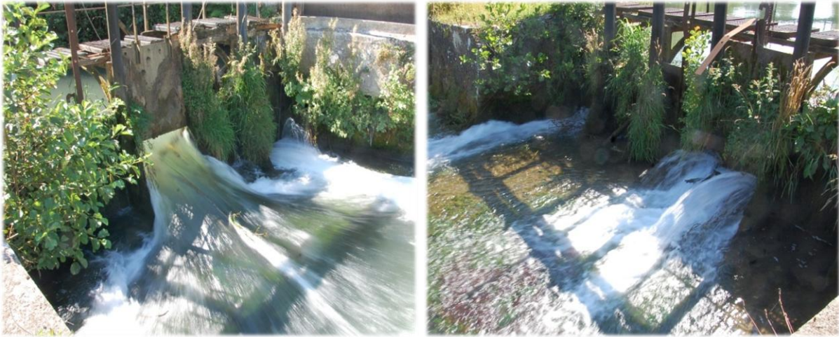
► Figure 48 : Photo de gauche, les 5 vannes en rive gauche, photo de droite, les 6 vannes en rive droite sur l'ouvrage principal (FDPPMA62)
