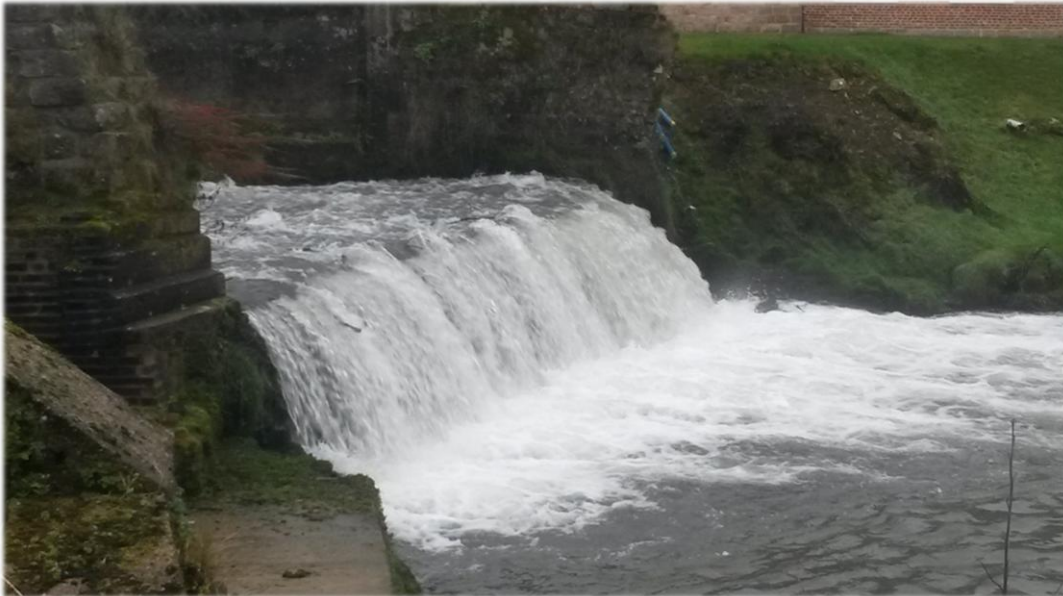
► Figure 53 : Vue en aval du premier seuil de l'ouvrage de Saint-Georges (ROE 20962) (FDPPMA62)
