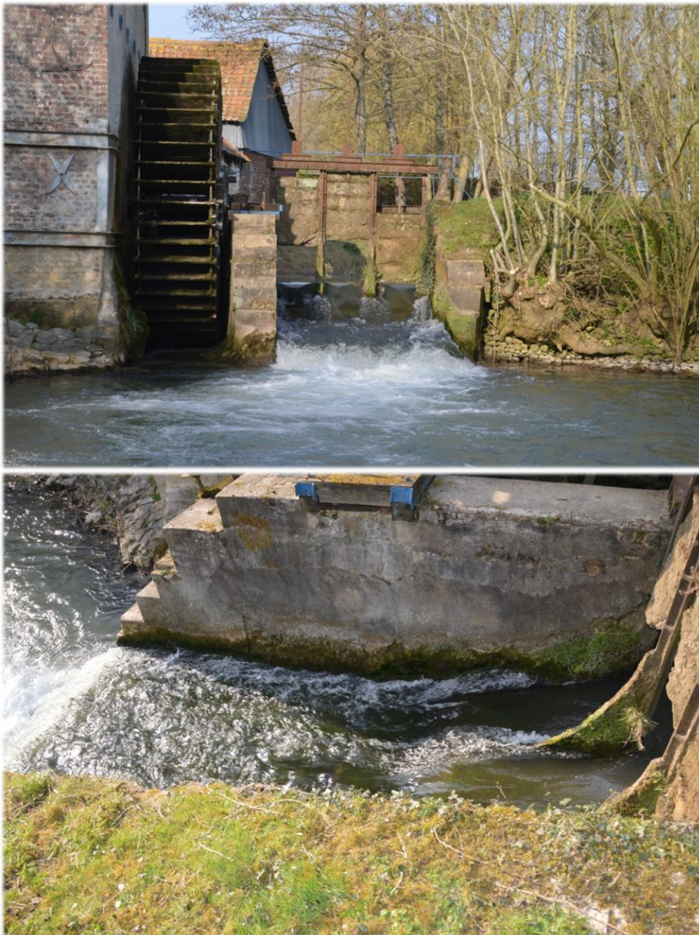
► Figure 68 : Ouvrage de la Bleuance (FDPPMA62)
