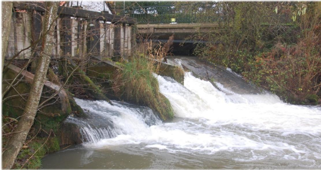
► Figure 62 : Ouvrage de Recques (FDPPMA62)
