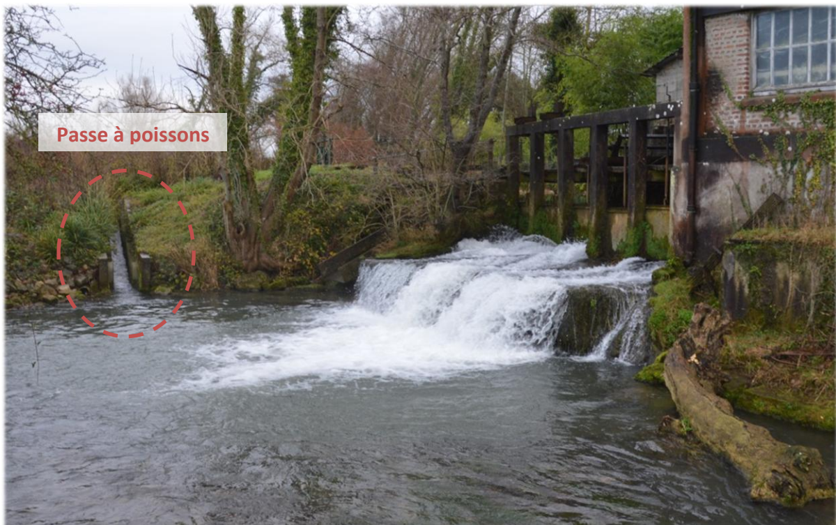
► Figure 59 : Ouvrage des Fordes (FDPPMA62)
