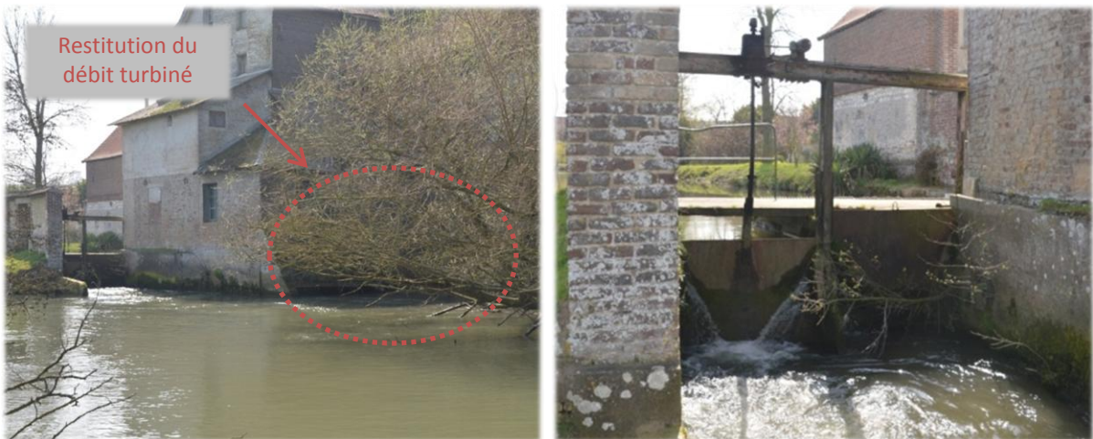
► Figure 49 : Photo de gauche, vue d'ensemble des vannes et de la sortie de la turbine (ROE 23478) sur la Fausse Canche (ouvrage secondaire), photo de droite, zoom sur les vannes (FDPPMA62)
