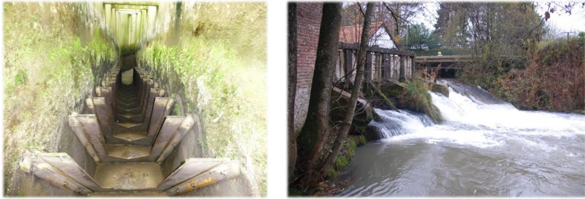
► Figure 104 : Photo de gauche, passe à ralentisseurs du barrage d'Auchy-lès-Hesdin adaptée pour les Grands Salmonidés mais non adaptée aux capacités de franchissement des lamproies marines et fluviales et photo de droite, barrage de Recques franchissable par les Grands Salmonidés mais difficilement par les truites fario (FDPPMA 62)
