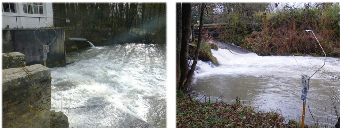
► Figure 20 : Exemples de récepteurs et antennes fixes installés sur le bassin, à gauche barrage de Blingel sur la Ternoise et à droite barrage de Recques sur la Course (FDPPMA 62)
