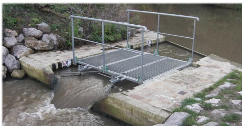
► Figure 10 : Exemple de situation dans laquelle aucune détection n'est possible à cause d'une turbidité trop élevée - Photo du 8 novembre 2016 (débit = 10 m 3 /s à Isques)
