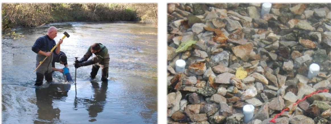
► Figure 8 : Mise en place des tubes PVC sur une frayère artificielle
