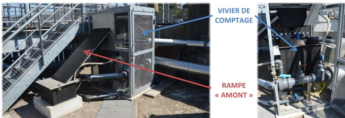
► Figure 9 : Rampe « amont » de la passe à anguilles et vivier de comptage
