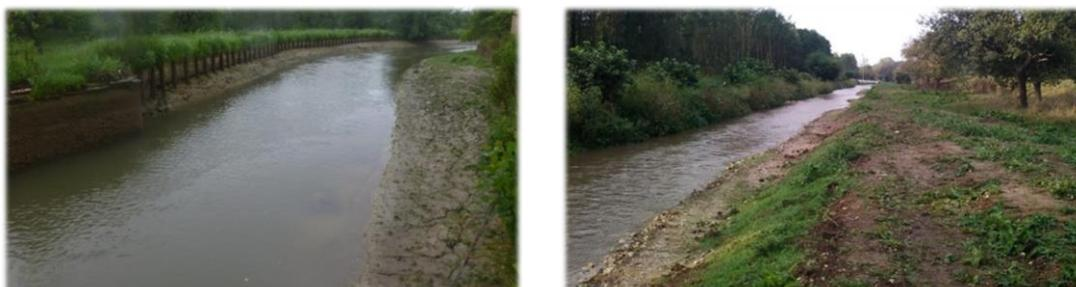
► Figure 7 : Barrage de Recques-sur-Hem, effet bief avec banalisation des habitats avant arasement (photo de gauche) & renaturation du cours d'eau après aménagement en 2016, avec diversification des écoulements et création de zones de reproduction (photo de droite)
