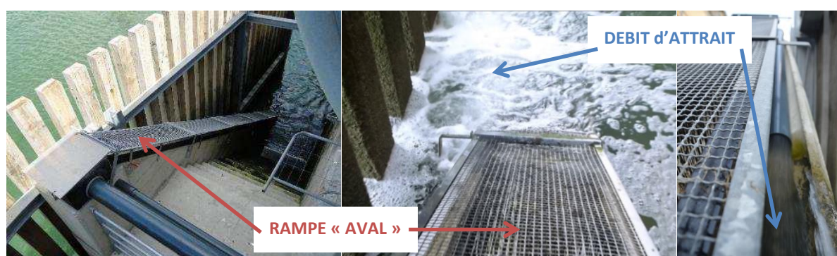
Figure 5 : Rampe « aval » de la passe à anguilles
