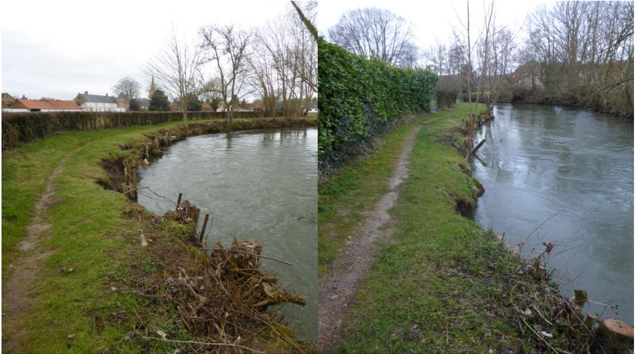
**Figure 2: Erosion de berge en rive droite**
