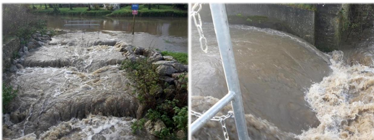
► Figure 10 : Passe à poissons suralimentée et vanne clapet ouverte à Mourlinghen le 11 décembre 2017 (débit instantané = 17 m 3 /s à Isques)
