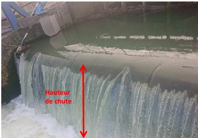
► Figure 15 : Hauteur de chute au niveau du barrage
