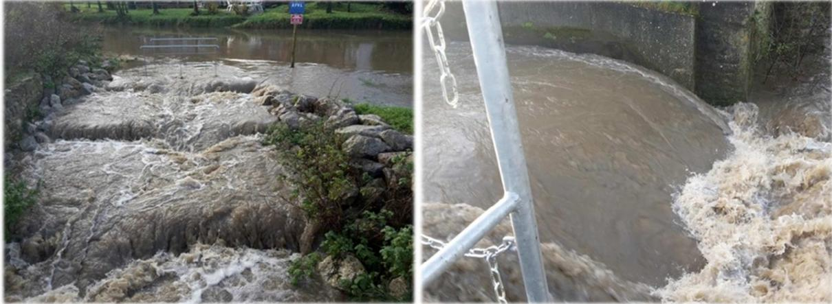
► Figure 10 : Passe à poissons suralimentée et vanne clapet ouverte à Mourlinghen le 11 décembre 2017 (débit instantané = 17 m<sup>3</sup>/s à Isques)
