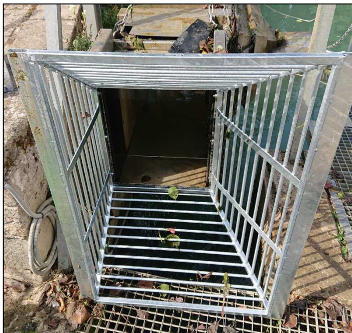
► Figure 8 : Pose du nouveau guideau sur le riverwatcher
