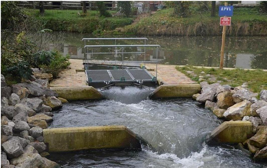
Figure 7: Riverwatcher installé à la sortie de la passe à poissons du barrage de Mourlinghen
