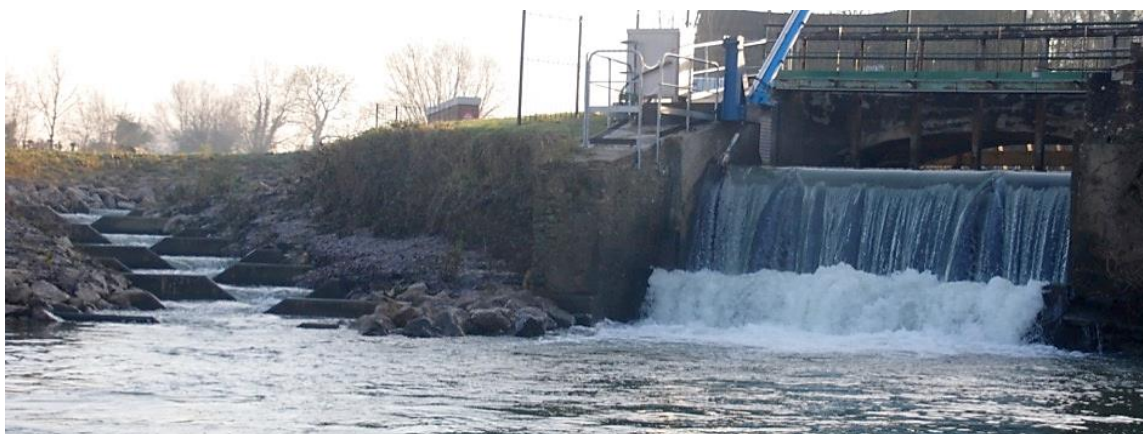
Figure 4 : Vue aval de la vanne clapet de Mourlinghen et de l'entrée de la nouvelle passe à poissons
