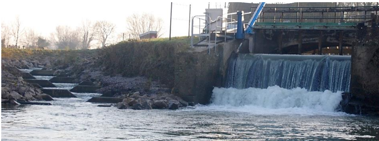
► Figure 4 : Vue aval de la vanne clapet de Mourlinghen et de l'entrée de la nouvelle passe à poissons
