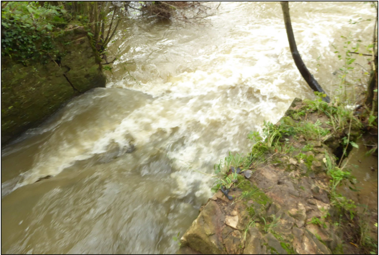
► Figure 3: radier de l'ouvrage en crue
