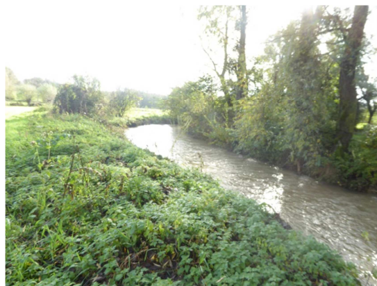
Vue du tronçon amont de l'ouvrage
