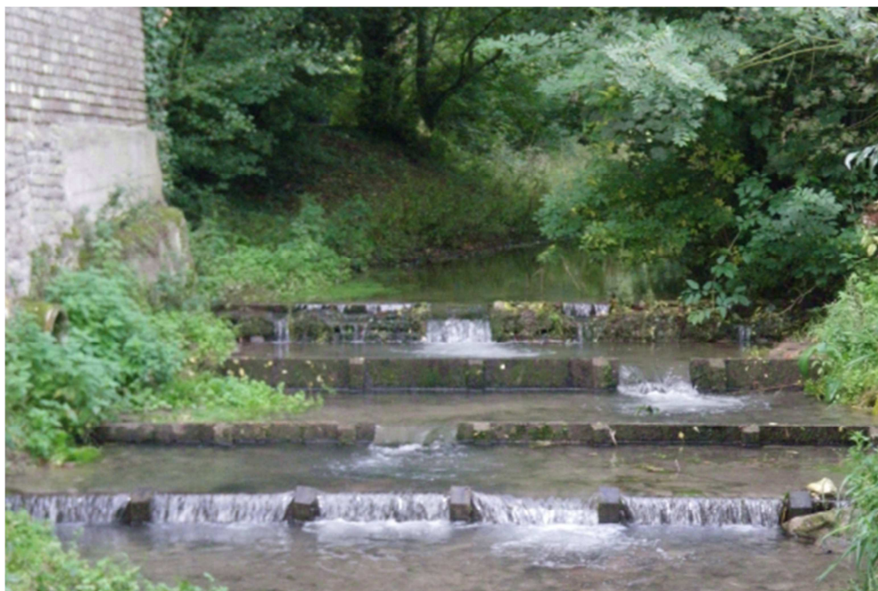
Photo 2 : Exemple de prébarrages sur le Crinchon
