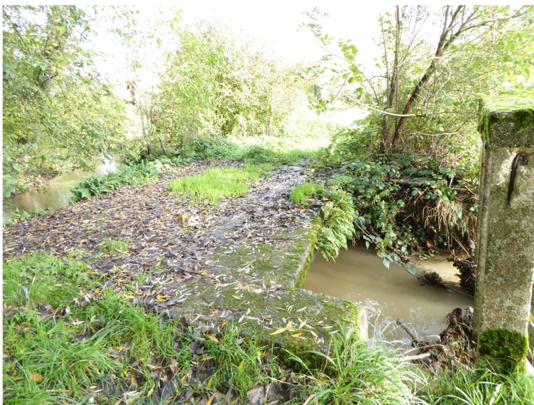
Passerelle à l'amont de l'ouvrage
