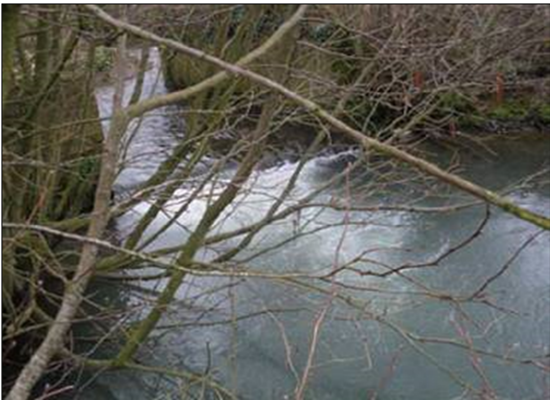
► Figure 4: vue de l'ouvrage par l'aval au module
