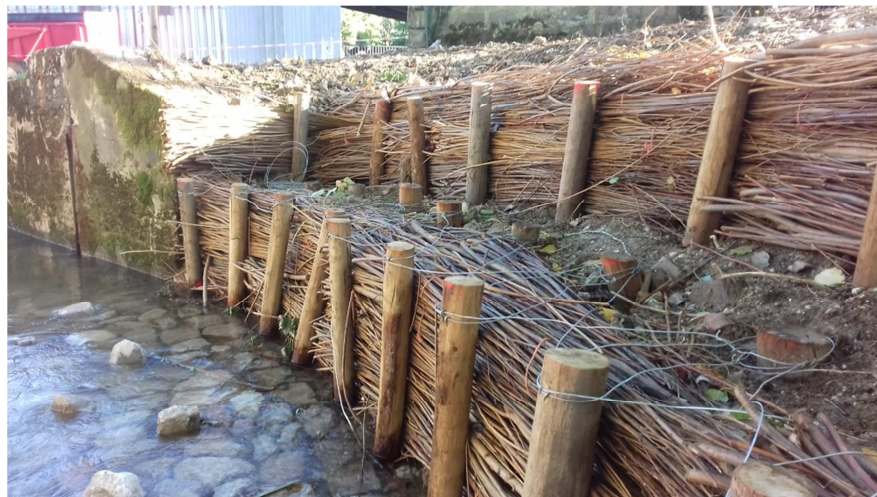
Photo 1 : Exemple d'ouvrage en génie végétal pour le maintien de berge
