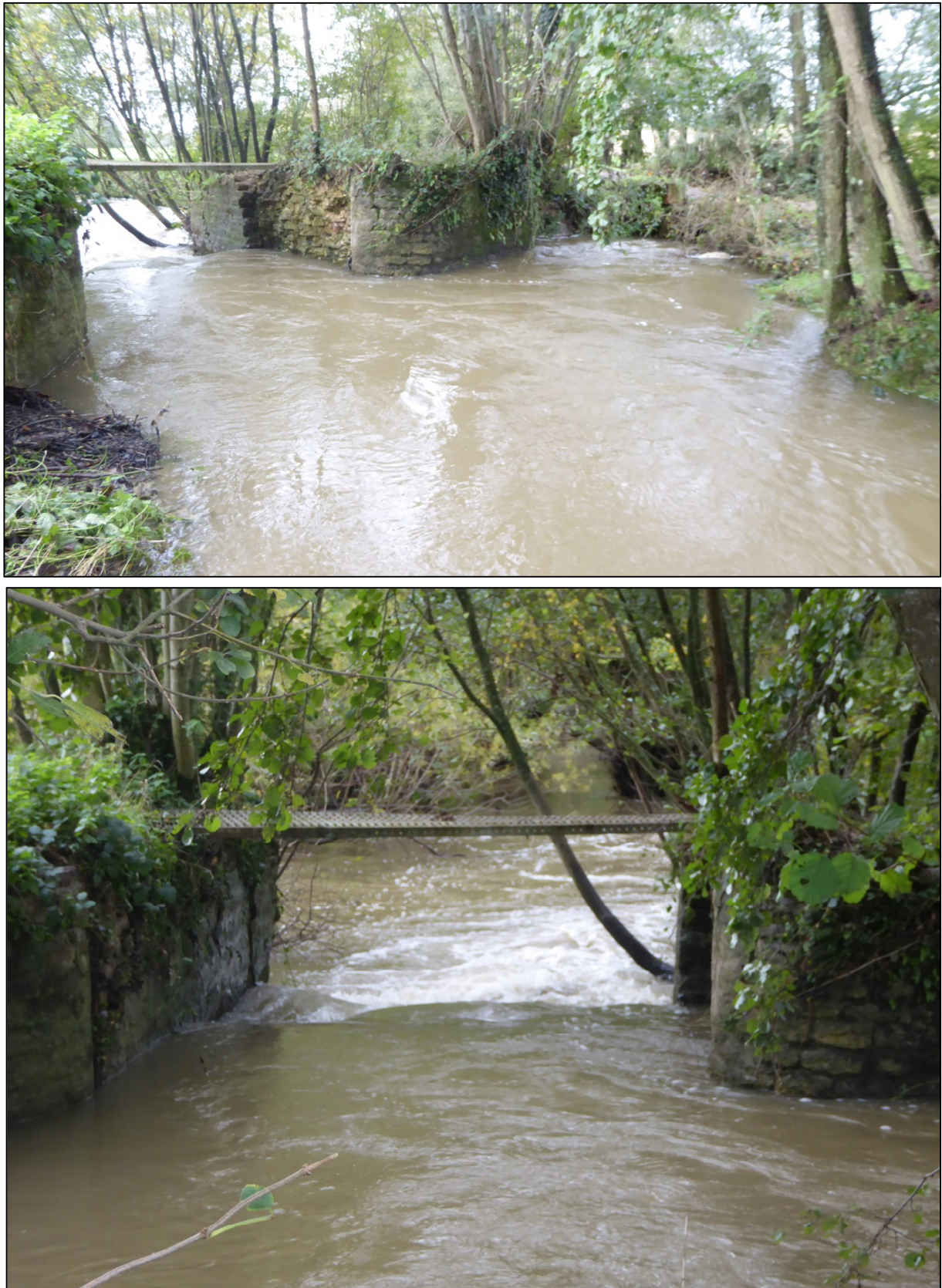
► Figure 2: vue de l'ouvrage par l'amont
