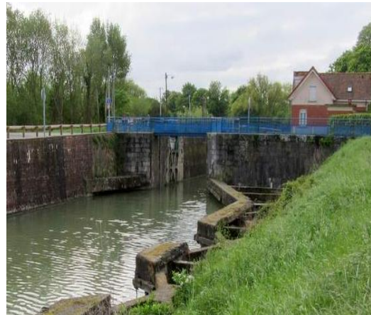
5b : Amont Saint-Bertin
