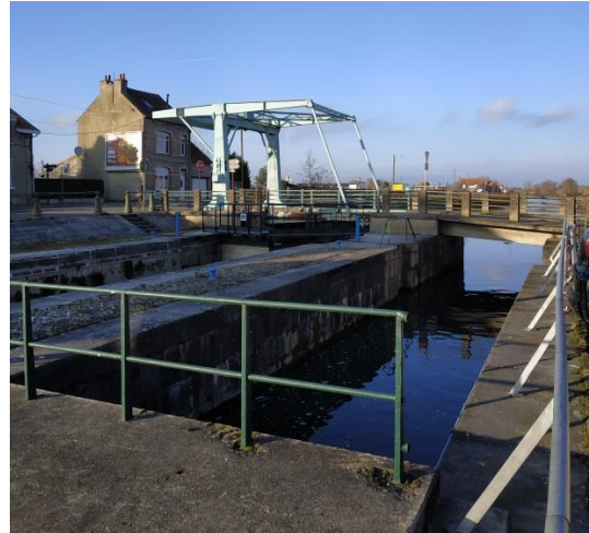
4-3 : Aval Hautpont immédiat
