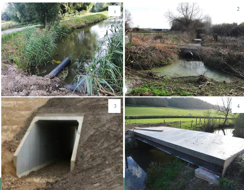
Figure 67 : Exemple de deux buses mal positionnées ne permettant pas le passage des géniteurs mais servant uniquement à la base à drainer la zone amont (1et2). Exemple de deux solutions améliorant la connectivité latérale (3 et 4) de manière optimale.
