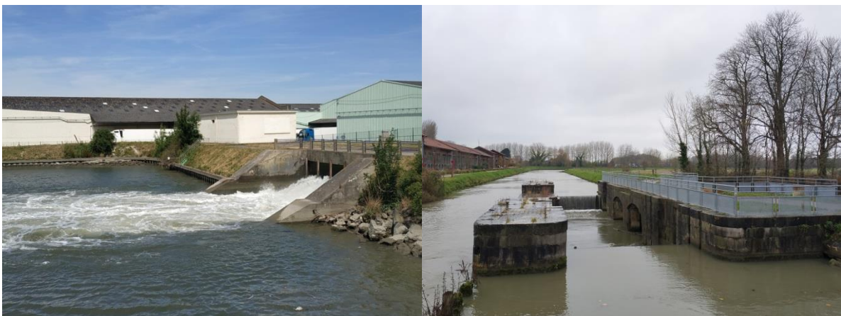
Figure 15 : Export des 2/3 de l'eau issue du sasement de l'écluse des Fontinettes dans le plan d'eau de Batavia (à gauche) et surverse entre le canal de Neuffossé et la Basse Meldyck au niveau de la maison du Grand Vannage (à droite).
