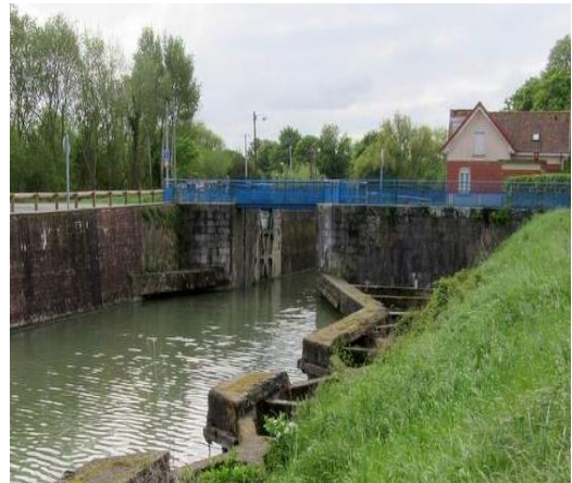
5b : Amont Saint-Bertin
