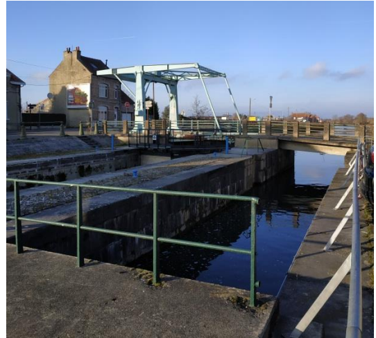
4-3 : Aval Hautpont immédiat
