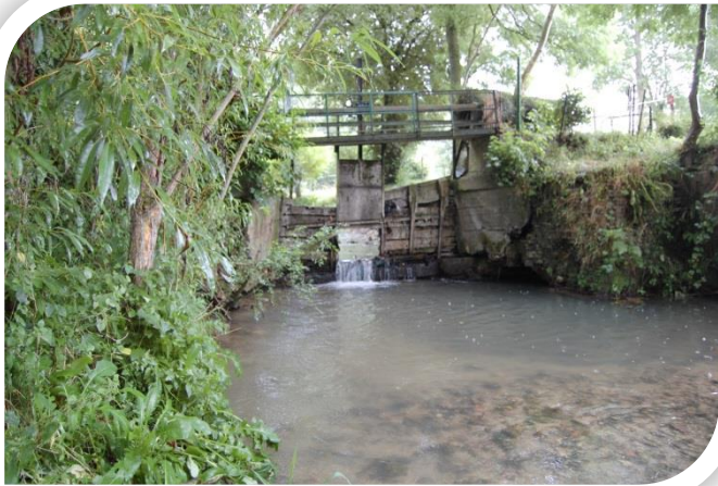
Ouvrage avant travaux
