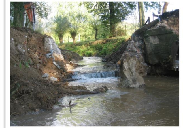
Arasement de l'ouvrage
