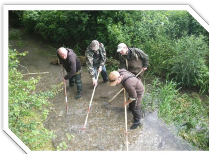
Décolmatage des radiers et création de frayères par recharges granulométrique
