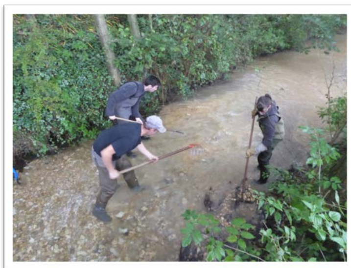
Création de frayères salmonicoles par recharges granulométriques
