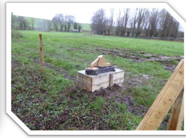
Installation de pompes à museau
