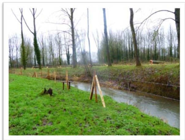
Mise en place de 2650 m de clôtures
