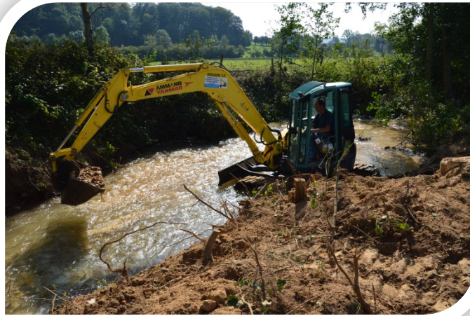
Arasement de l'ouvrage
