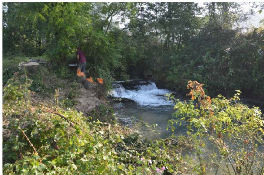
Ouvrage avant les travaux
