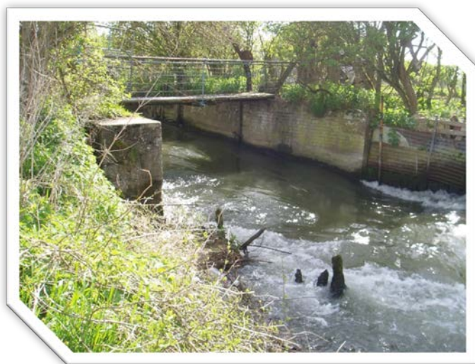
Ouvrage avant les travaux
