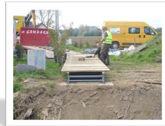
Remplacement de la passerelle piétonne
