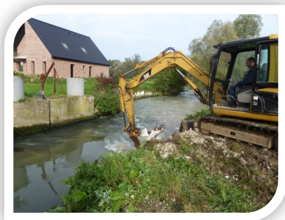
Arasement de l'ouvrage
