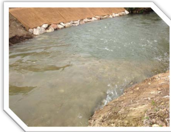
Recharge granulométrique de la fosse de dissipation
