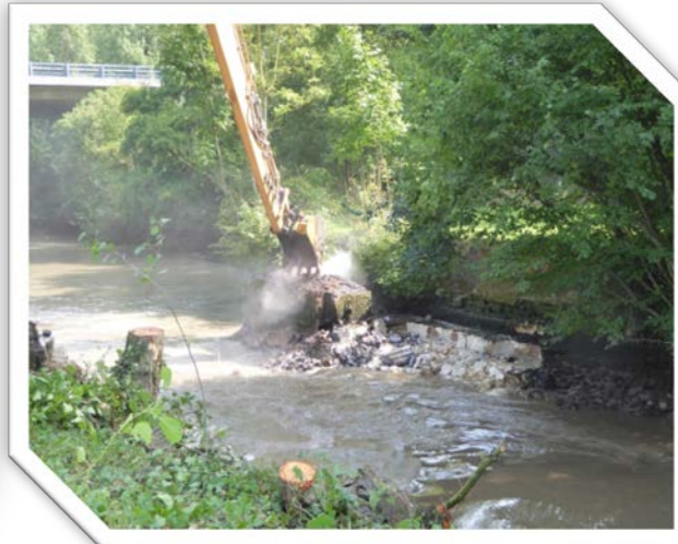
Arasement de l'ouvrage
