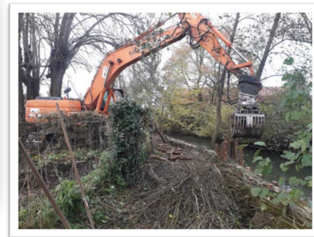
Réalisation de l'ouvrage de la fascine de saules vivants
