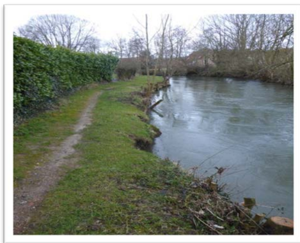
Etat initial avant travaux
