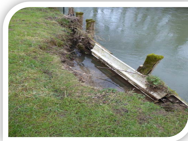
Anciennes protections de berges inefficaces
