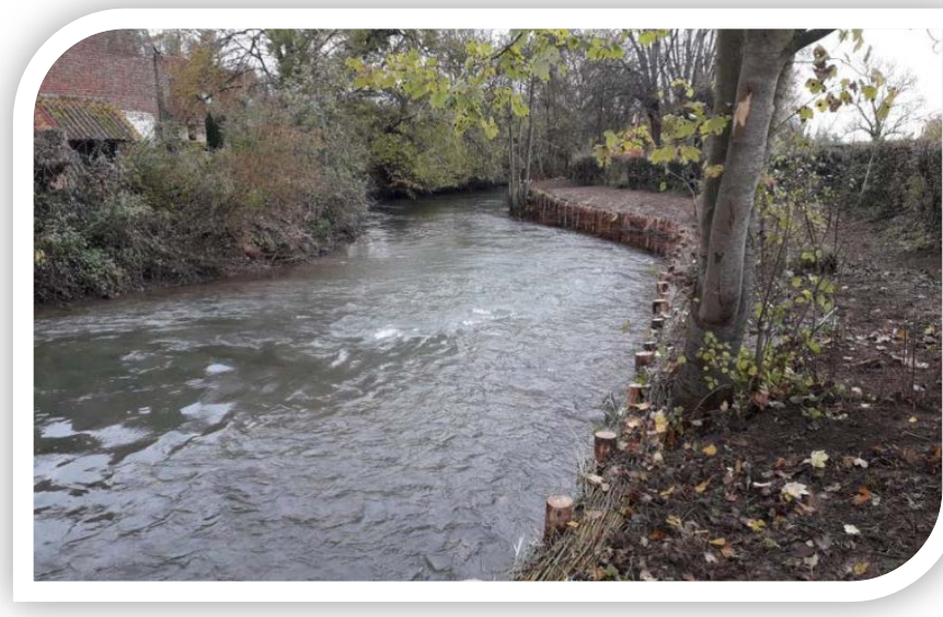
Etat final après travaux
