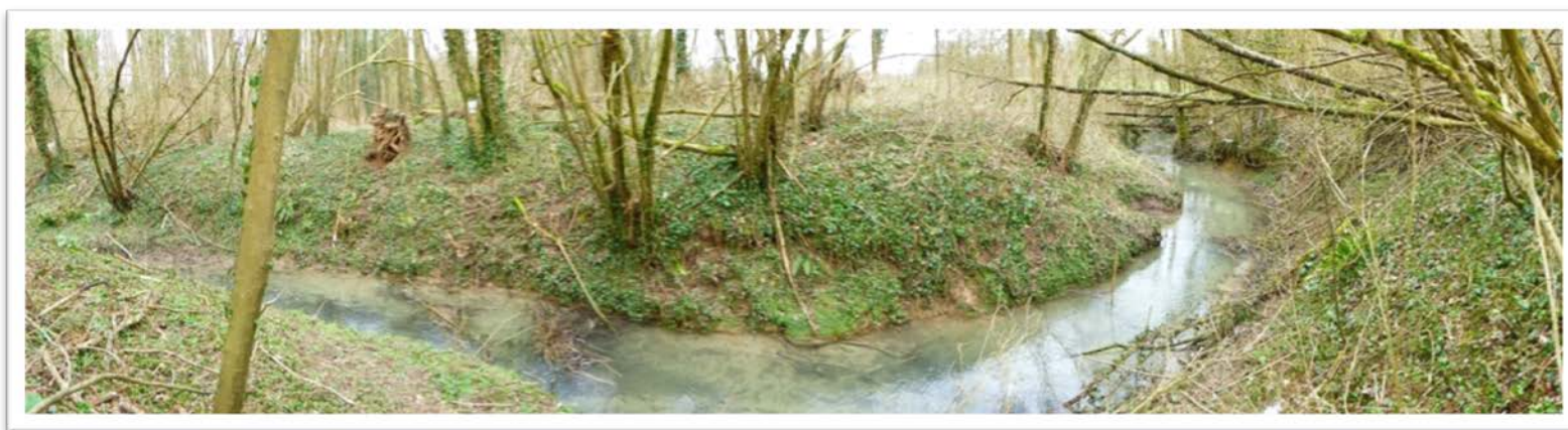
Etat initial du ruisseau
