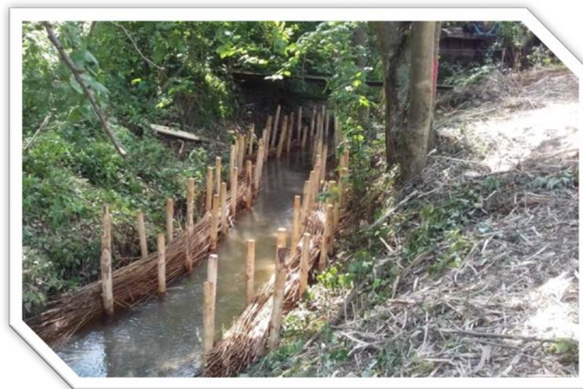
Mise en place de la fascine de saule
