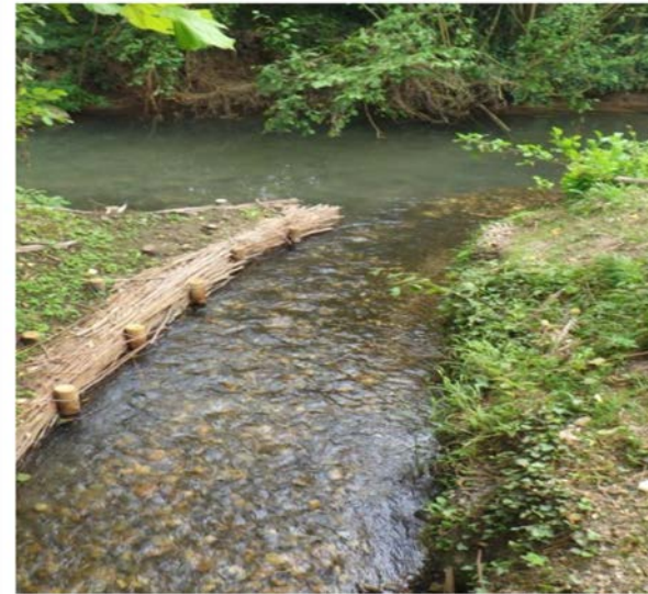
Confluence du ruisseau avec l'Authie après les travaux
