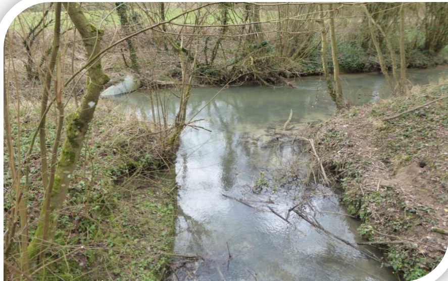
Confluence du ruisseau avec l'Authie avant les travaux
