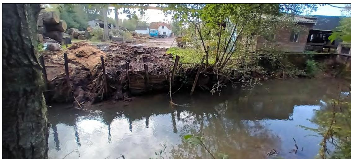
Figure 8: Anciennes protections de berges en rive droite à l'amont de l'ouvrage
