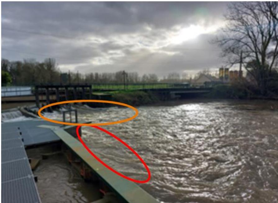
Figure 15 : Photographie de la passe à poissons de Douriez le 23/11/2023, montrant en rouge le manque d'attrait de la passe à poissons en opposition des 3 vannes ouvertes (ellipse orange).
