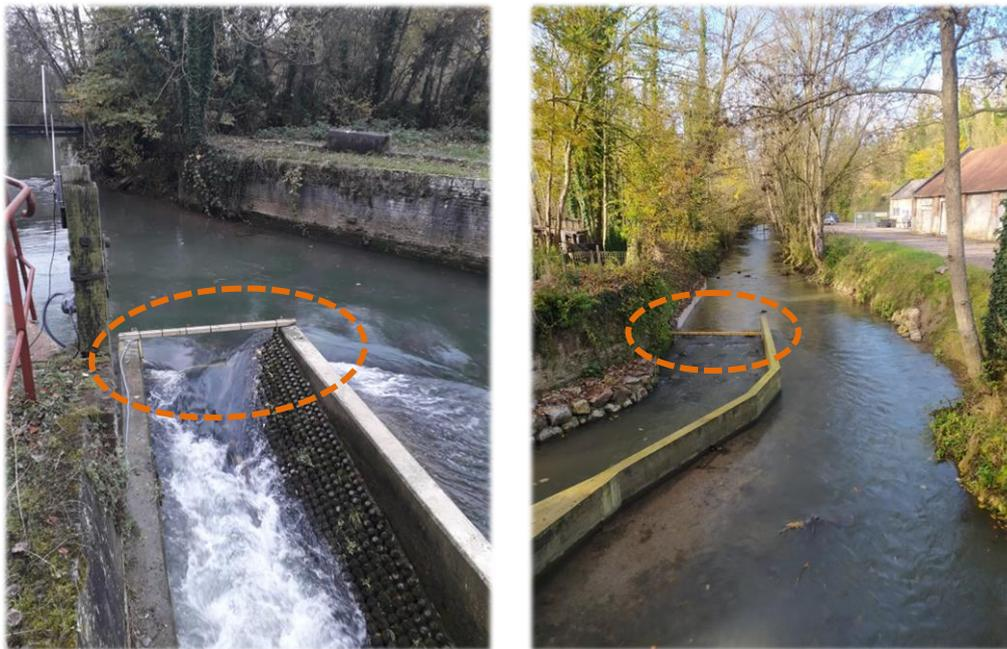
Figure 22 : Photographies des antennes de radio-identification, à gauche, en sortie de la rampe en enrochement de moulin Colbert, et à droite, en sortie de la passe à ralentisseurs de moulin Snick
