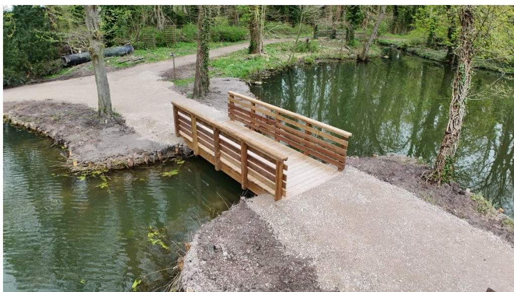
Figure 6 : Exemple de passerelle en bois présent sur site
