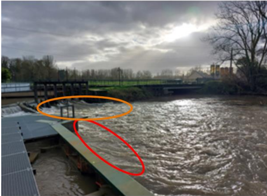
Figure 16 : Photographie de la passe à poissons de Douriez le 23/11/2023, montrant en rouge le manque d'attrait de la passe à poissons en opposition des 3 vannes ouvertes (ellipse orange).
