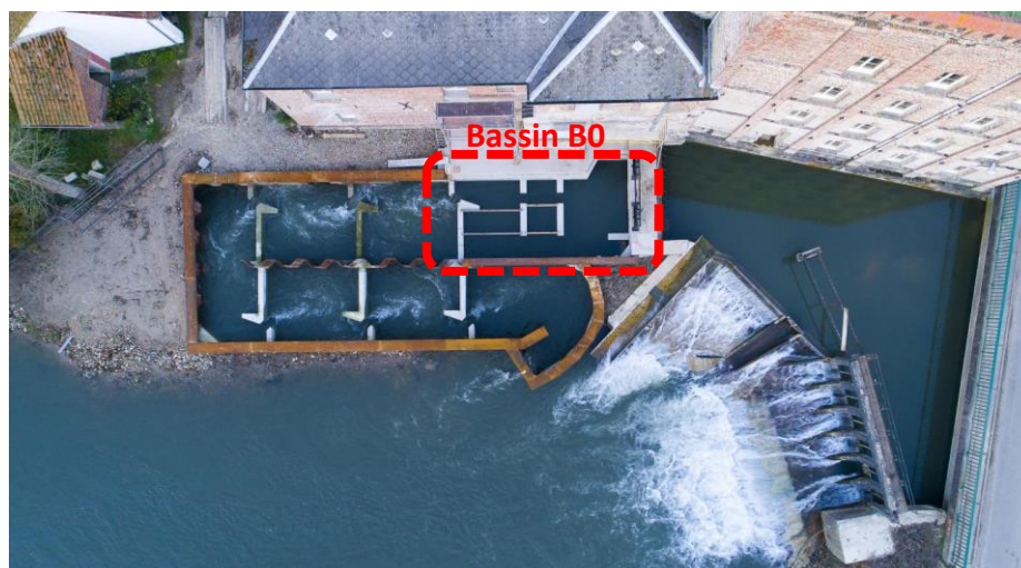
Figure 11 : Photographie aérienne de la passe à poisson de Douriez pendant la phase de travaux (La voix du Nord, 04/01/2022)
