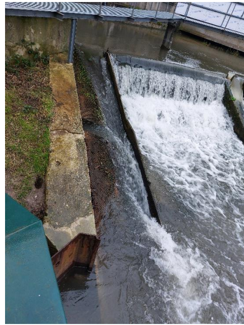
Figure 5 : Rampe à anguille de type substrat picots
