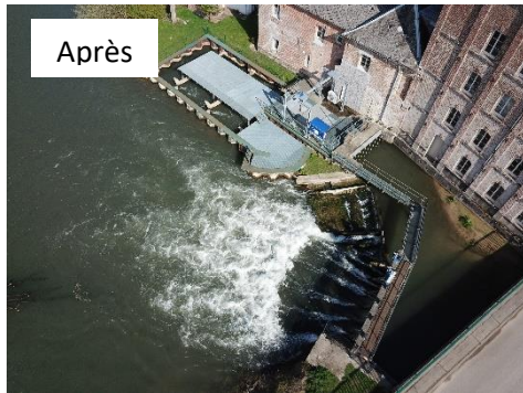
Figure 4 : Ouvrage de Duriez avant travaux et après la création des dispositifs de franchissement piscicole
